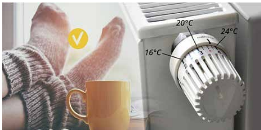
Auf dem Thermostat sind die einzelnen Stufen noch einmal durch drei Striche unterteilt. Jeder Strich steht für einen Grad.
